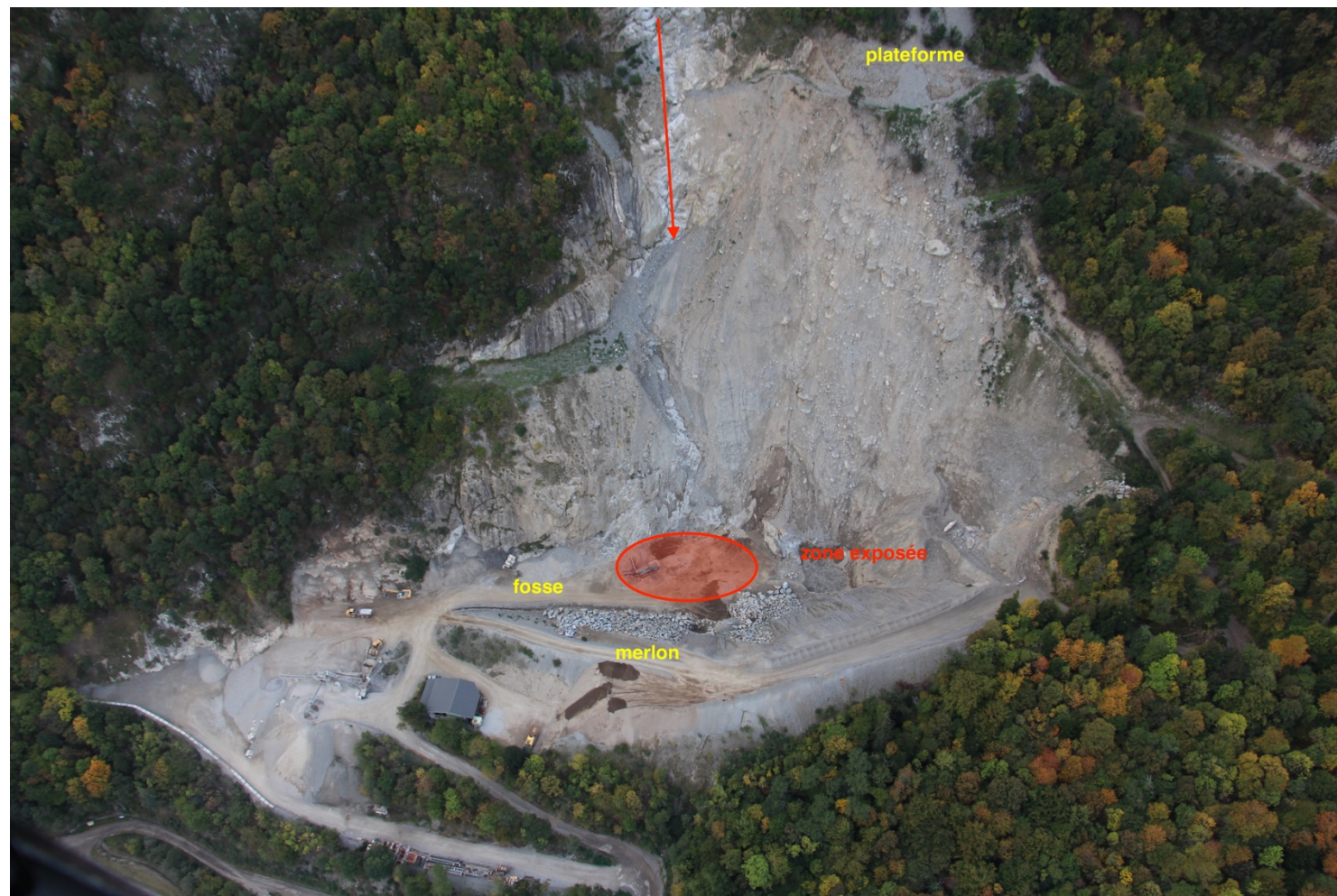
Vue générale des installations
