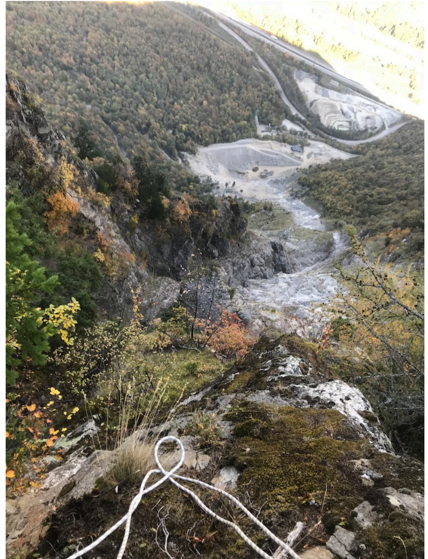
Vue générale du couloir
